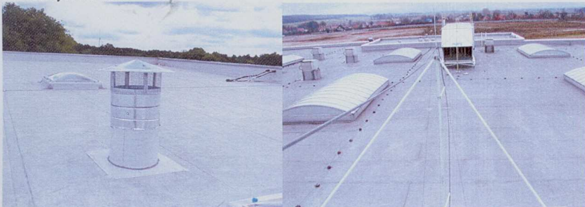
Pokrycie Budynku Biurowo – Produkcyjnego Browar Łomża Sp. z o.o. Łomża ul. Poznańska 121 po zakończonych robotach
